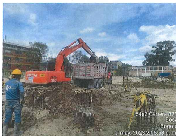
Cargue de material excavado por pilotaje. Fecha: 09-05-2023.
